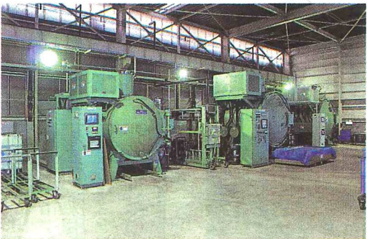
完成間近の清水倉庫①、熱処理センターに増設した真空熱処理炉
